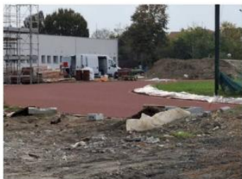
I lavori della pista di atletica al centro sportivo
