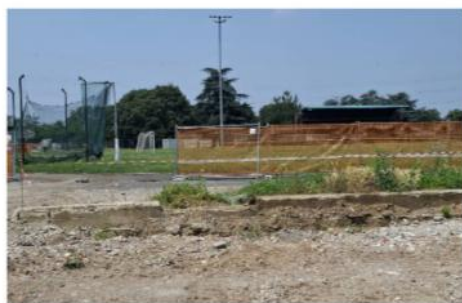
I lavori in corso al centro sportivo di via Europa
